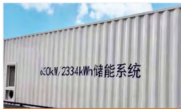
📍 海纳川储能电站 储能：783kWh
