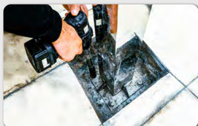
棚式立柱安装
