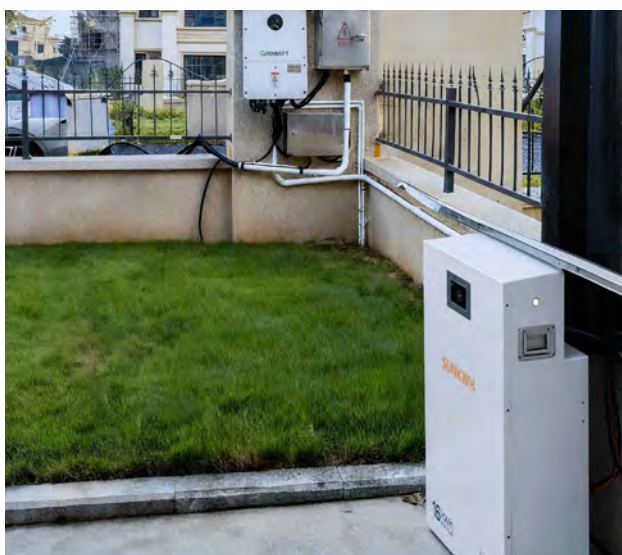
📍 佛山 光伏：12.9kW 储能：16kWh
